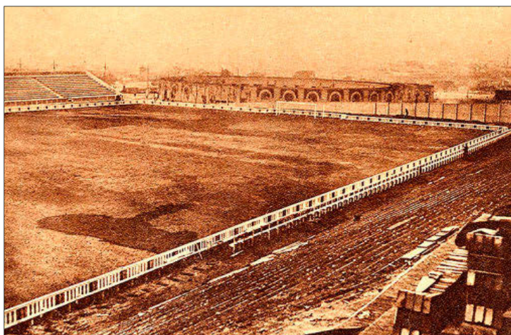
El Estadio de Vallecas a punto de terminar su construcción. E. M.
