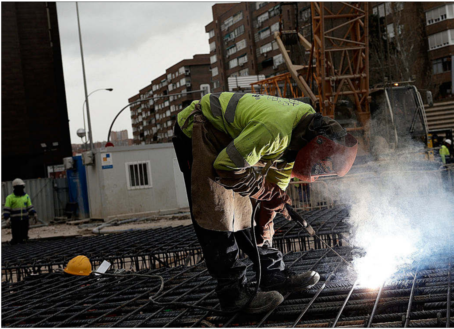
Un trabajador en las obras del intercambiador de transportes de la plaza de Conde de Casal, en Madrid. ANTONIO HEREDIA
